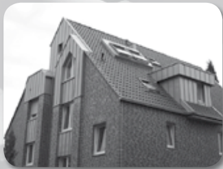
Klempner- und Fassadenarbeiten
